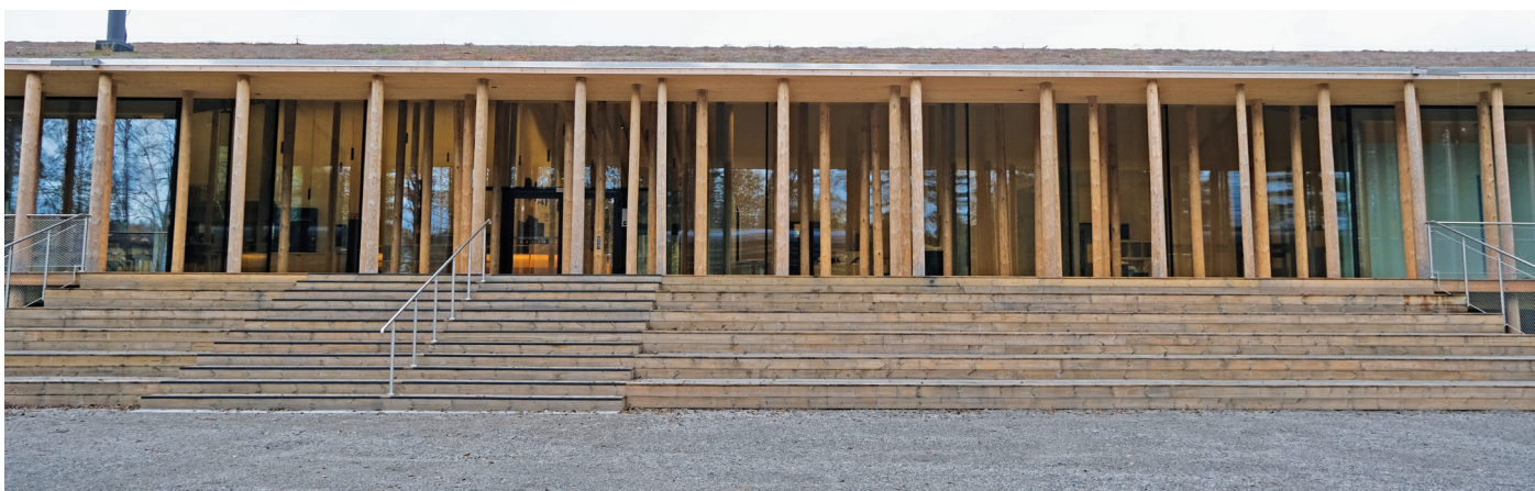
Langs fasaden er det montert 380 søyler av hele trestammer. Trappen fungerer også som sitteplasser foran den utvendige scenen.
